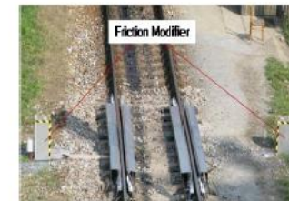
Radsatzschmieranlage
